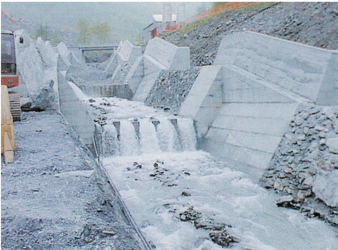
Cantiere della Val Clarea: nuovo inalveamento Rio Clarea visto da valle.
