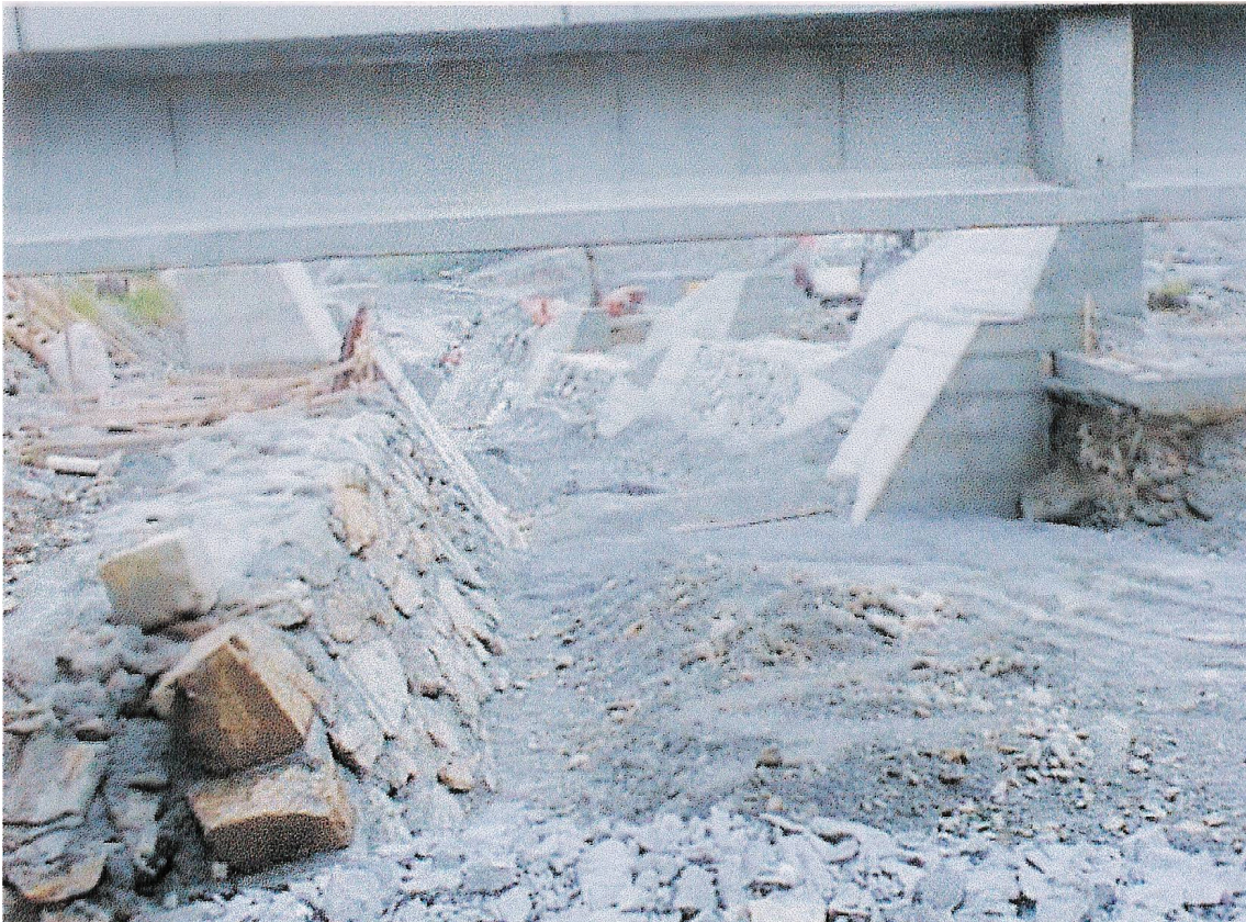
Cantiere della Val Clarea: nuovo inalveamento Rio Clarea visto da monte.
