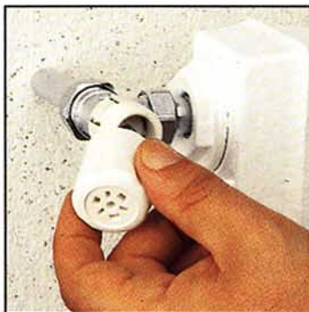
Trasformazione di una valvola predisposta: da comando manuale (tradizionale) a termostatica
