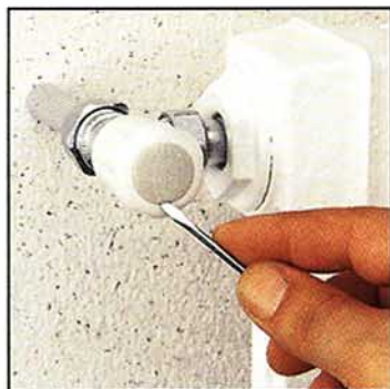
Trasformazione di una valvola predisposta: da comando manuale (tradizionale) a termostatica
