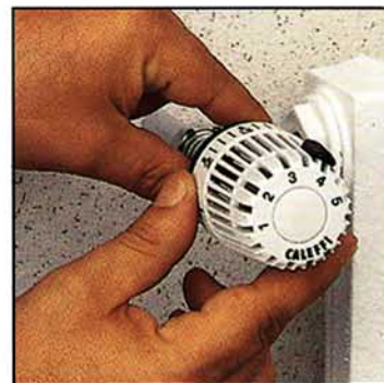
Trasformazione di una valvola predisposta: da comando manuale (tradizionale) a termostatica
