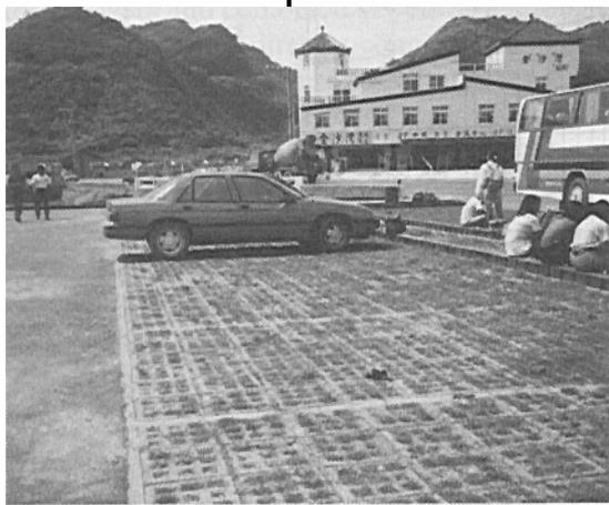
Può essere realizzata con asfalto o cls permeabile o con elementi perforati in cls. Lo strato filtrante sottostante può anche essere isolato con una guaina impermeabile, trasformandosi in una specie di vasca di laminazione.
